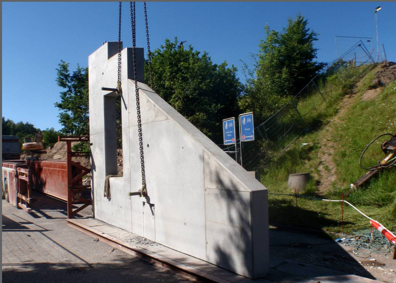
Præfabrikeret fløjvæg ved vederlag
