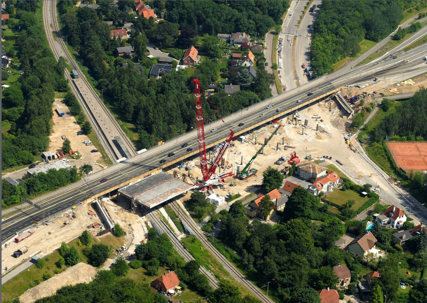
Montage af broelementer
