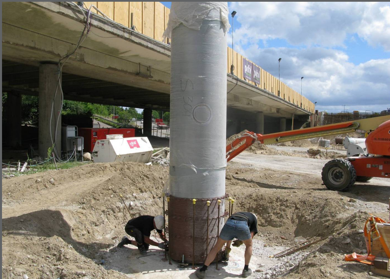
Søjlemontage på eksisterende fundament
