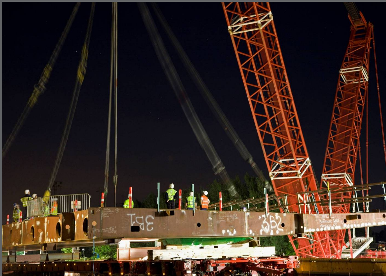
Montage med 750 tons kran
