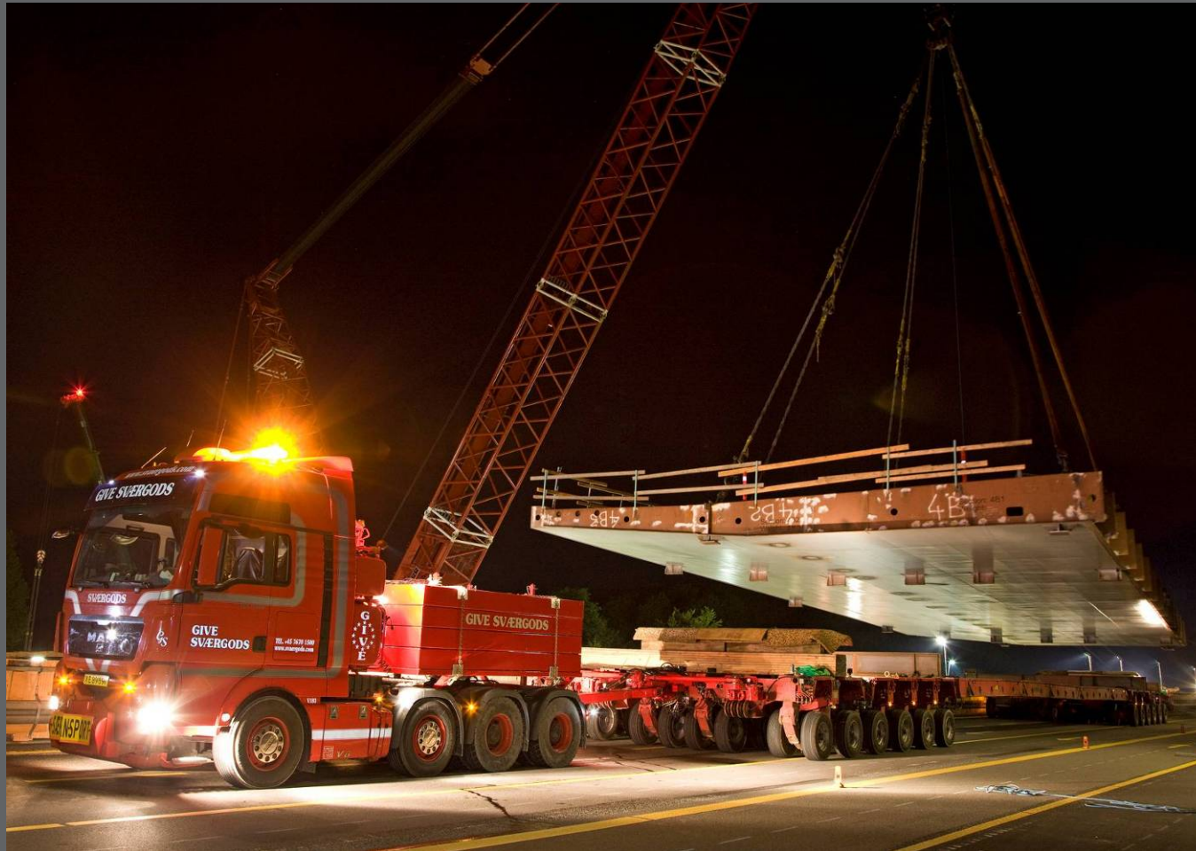
12 broelementer transporteres til Skovdiget og monteres med kran. Dag 14 - 19
