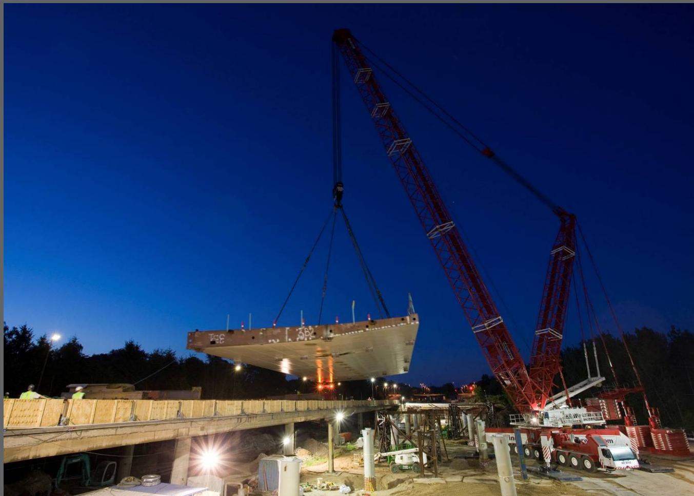
Montage med 750 tons kran
